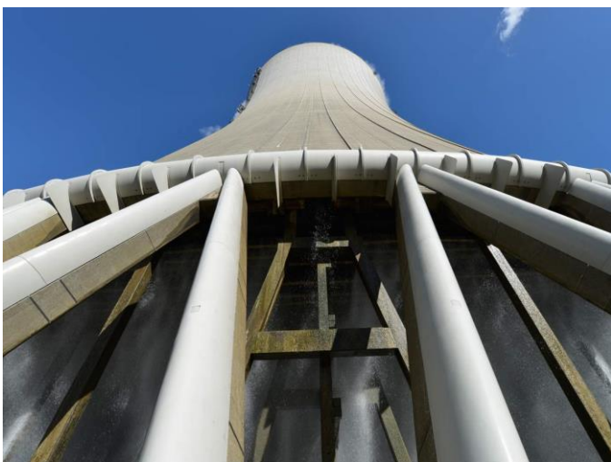
Kühlturm, KKW Gösgen
